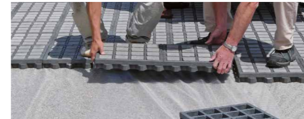
TTE® Elemente verlegen, indem die Verzahnung ineinandergeschoben wird.
